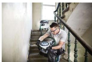
Die Diamantscheibe DIA Thermo Premium D130 für die RG 130 eignet sich besonders gut bei schwer abzuschleifenden Materialien, die durch Hitze beim Schleifen verschmieren. Durch die Anordnung der Diamanten wird das Material eher geschabt als geschliffen und somit kann sich die Scheibe nicht zusetzen - ein sehr schneller Abtrag kann erzielt werden. Zeitsparend zum besten Ergebnis.
